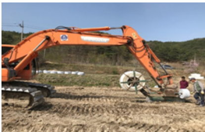
간척지 무굴착 암거배수 시공
